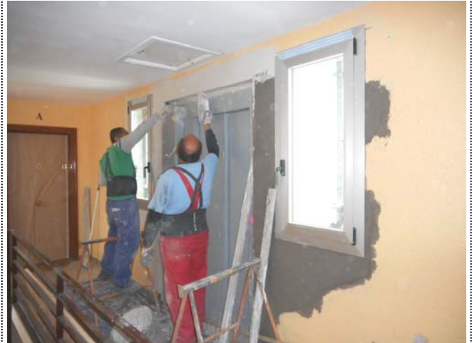
Foto 2760. 15/04/2015. Iniciando remates interiores de reconstrucción de huecos . Realicense completos por plantas, cerrando tajos, de arriba hacia abajo. Esmérese la limpieza y protección de la carpintería o cualquier otro elemento que pueda dañarse.
