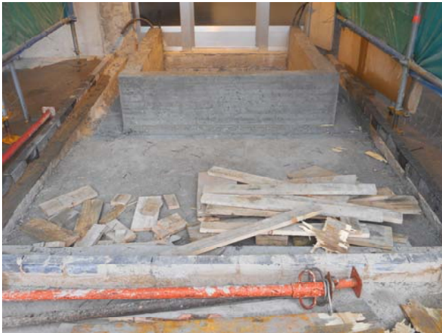
Foto 1652. 5/12/2014. Finalizado hormigonado de paredes de recinto. Desmontando encofrado. Retírense los materiales sobrantes.
