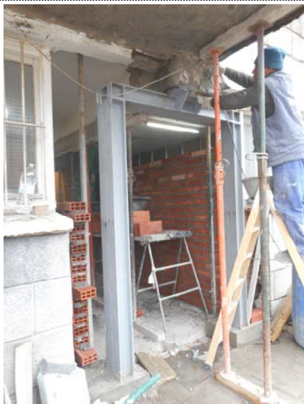
Foto 1728. 11/12/2014. Preparando construcción de cerramiento exterior sobre nuevo acceso. Espérense directrices precisas para ejecutarlo.
