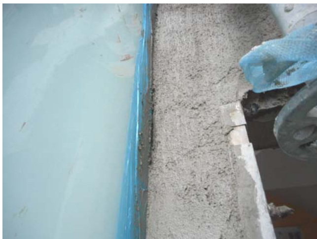
Foto 2967. 29/04/2015. Se comprueba proceso de ejecución de encuentro de enfoscado de fachada con acristalamiento del recinto. Se ha dispuesto una protección provisional del vidrio y se prepara la junta que permite dilataciones (posteriormente se sella; véase F2960).
