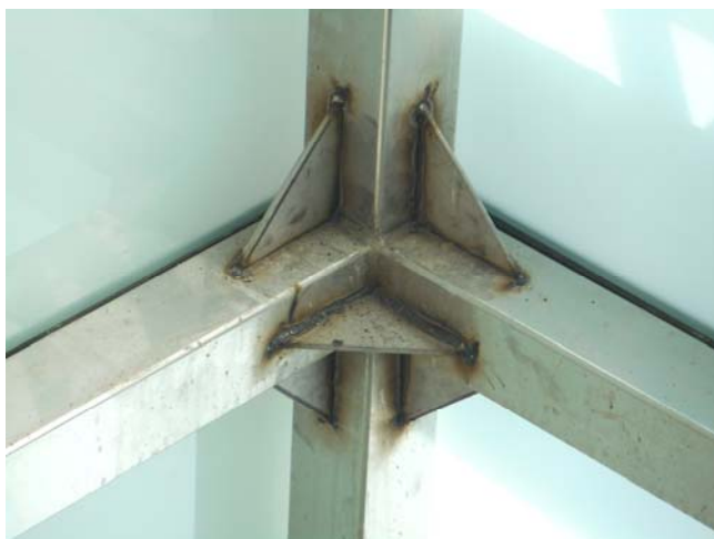
Foto 2327. 10/03/2015. Se comprueba colocación de rigidizadores de nudos. Límpiase la zona intervenida. Revisese el acabado del acero inoxidable.
