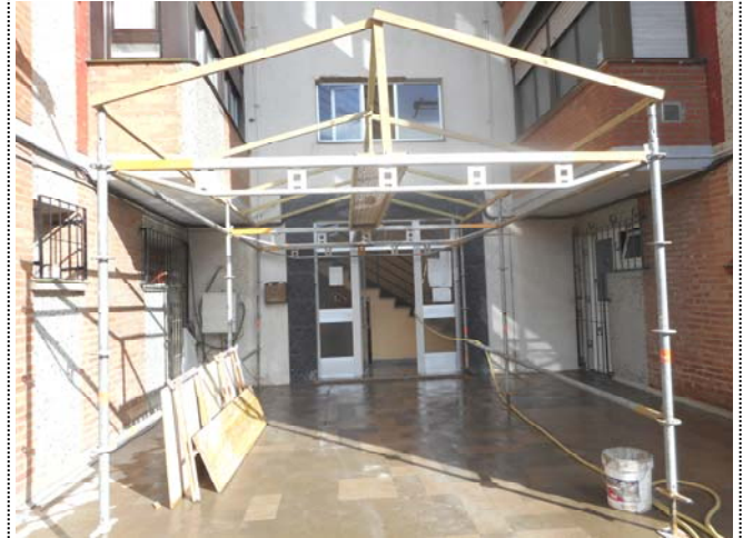
Foto 1487. 18/11/2014. Preparando protección para demolición del forjado . Asegúrese su estabilidad frente a la acción del viento (muy fuerte en la zona).
