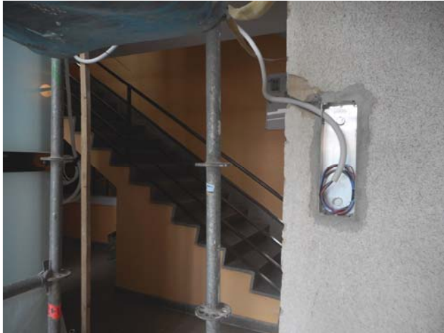
Foto 2756. 15/04/2015. Rematando instalación de porteros automáticos .
