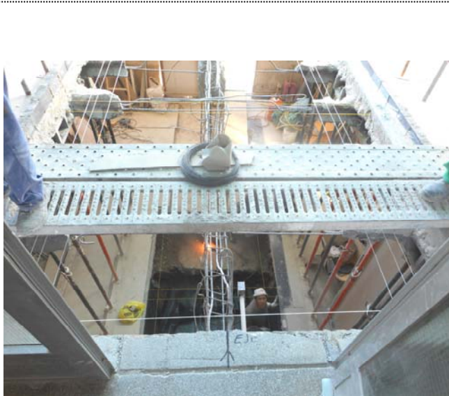
Foto 1517. 20/11/2014. Demolido el forjado superior (plta. de acceso al portal). Se comprueba ubicación del eje del recinto del ascensor y disposición de cuerdas de replanteo.
