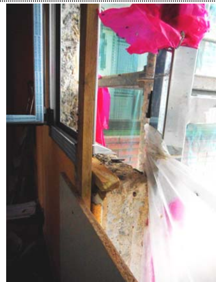
Foto 2193. 18/02/2015. El Constructor presenta muestra de ventanas, corresponde con las especificaciones del proyecto. El encuentro con el castillete metálico se resolverá construyendo una mocheta de fábrica. Asegúrese la estanqueidad por el exterior.
