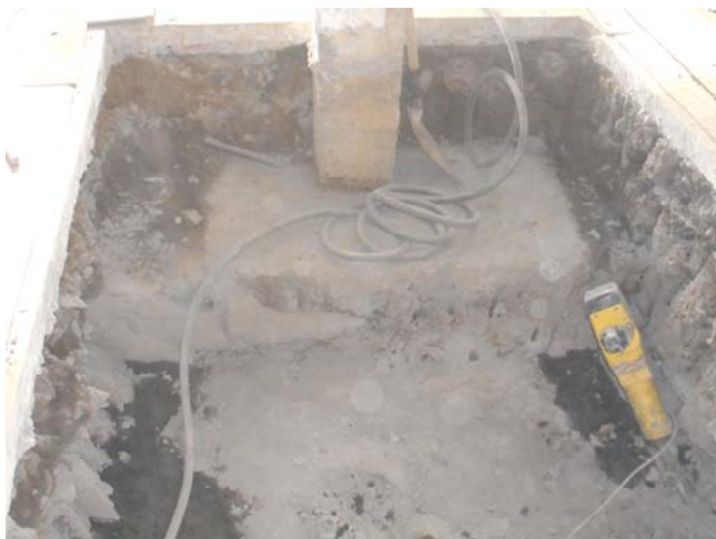
Foto 1448. 12/11/2014. Afinando paredes de la excavación. Respétese la zapata descubierta, extiéndase el hormigón de limpieza y replantéese la planta del recinto completo .
