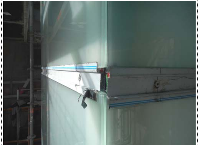
Foto 2325. 10/03/2015. Se comprueba colocación de vidrios sobre apoyos de pletinas. Es chapucera, corríjase. Se dieron instrucciones precisas (véase Memoria 18/febrero; foto 2191).
