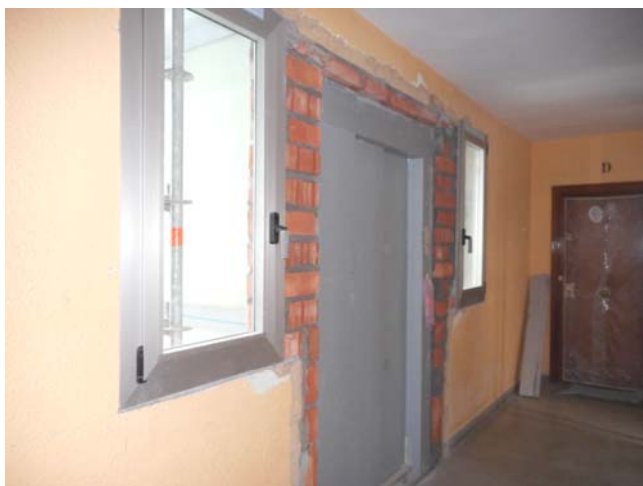
Foto 2763. 15/04/2015. Construyendo cierres de fachada (plta. 3ª y bajando). Es necesario agilizar la ejecución; debe evitarse la dilación del programa de obra.
