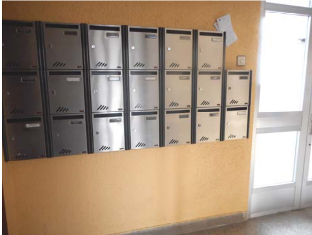
Foto 1409. 07/11/2014. Preparando apertura de nueva puerta de acceso a portal . Es necesario trasladar los buzones de correos. Colóquense provisionalmente en la pared situada debajo del primer tramo de las escaleras.
