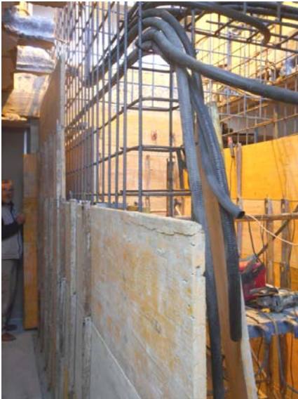
Foto 1647. 02/12/2014. Se comprueba disposición de tubos para introducir los cableados eléctricos. Asegúrese la fijación s/la ferralla (Deben mantener la posición durante el hormigonado).
