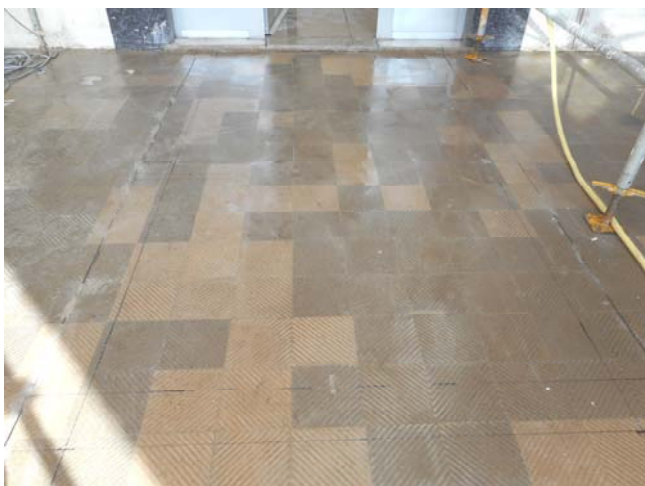
Foto 1488. 18/11/2014. Preparando inicio de demolición del forjado. Replanteado y precortado perímetro exterior de pared del recinto de hormigón armado . Se dan indicaciones (ver foto 1491).
