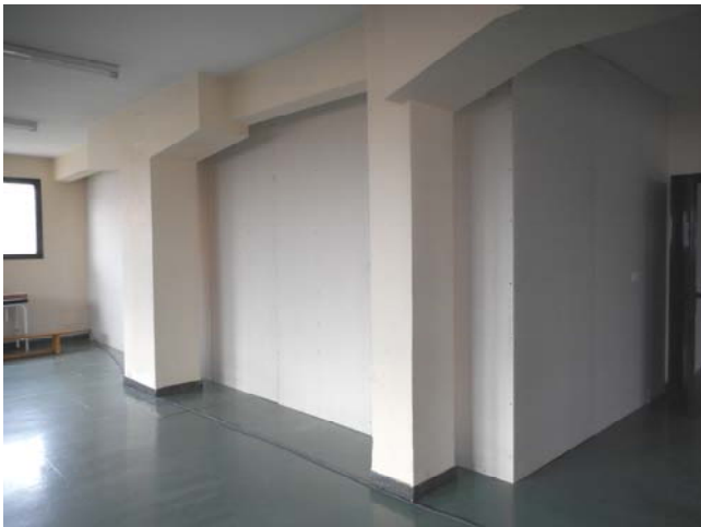
Foto 1417. 07/11/2014. Se comprueba la construcción del cierre de separación entre la zona de obra y el resto del local . Ejecutado según lo planteado durante la comprobación del replanteo.
