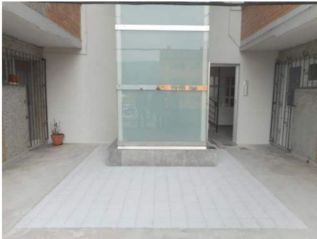
Foto 8201. 02/06/2015. Se comprueba remate de zócalo de recinto sobre patio. Es correcto.
