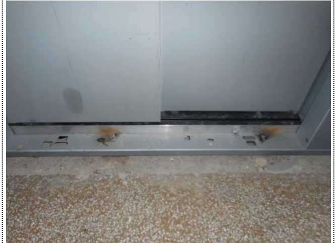
Foto 2622. 31/03/2015. Se comprueba nivelación de umbrales de puertas de ascensor con descansillos de escaleras. Es correcta.
