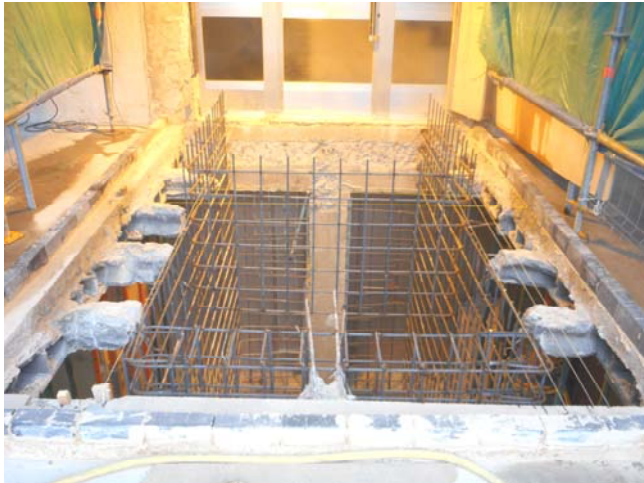
Foto 1624. 01/12/2014. Finalizando colocación de ferralla en paredes. Asegúrense los recubrimientos proyectados, mediante separadores.
