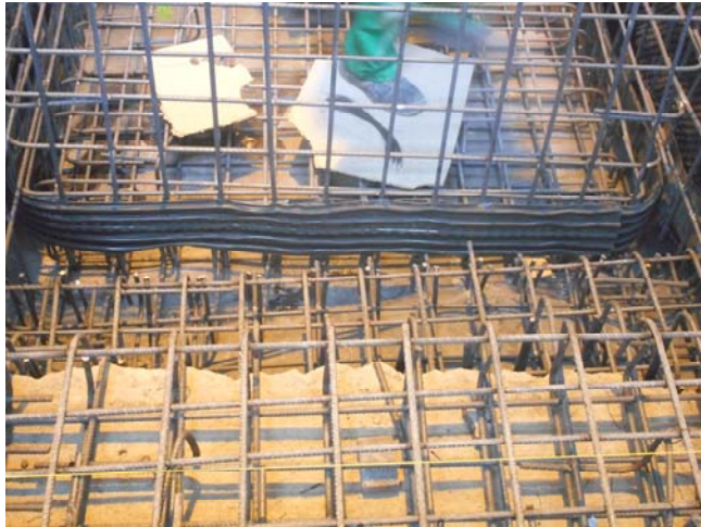
Foto 1542. 24/11/2014. Se comprueba instalación de junta de estanqueidad (transversal a la junta de hormigonado: zapata/muros). Asegúrense las fijaciones a la armadura durante el hormigonado. Se comprueba colocación de separadores .
