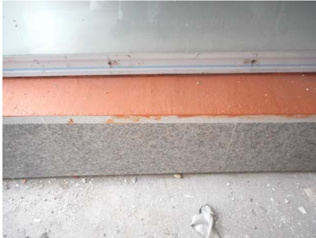
Foto 3035. 12/05/2015. Ejecutado zócalo de recinto de ascensor s/patio abierto . Pendiente de rematar con albardilla metálica. Véanse pliegues proyectados; asegúrese la indeformabilidad longitudinal de la chapa.
