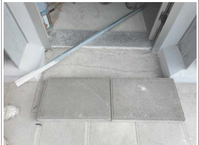
Foto 3066. 12/05/2015. Se dan directrices para ejecutar el umbral de acceso al vestibulo de la plta. baja . Hasta la alineación de fachada se pavimentará con el mismo material que la acera (según se dispone en la foto), en el espesor del muro se colocará un plano inclinado de granito abujardado (una pieza única); asegúrese que no es resbaladizo.
