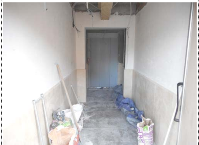
Foto 2968. 29/04/2015. Finalizando acabados en el nuevo vestíbulo (plta. BBK). Cuidense los remates de los aplacados de zócalo.
