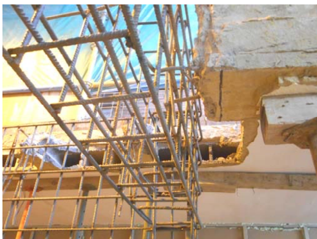
Foto 1629. 01/12/2014. Se comprueba disposición del apoyo de la jácena cortada sobre el nuevo muro de h.a.
