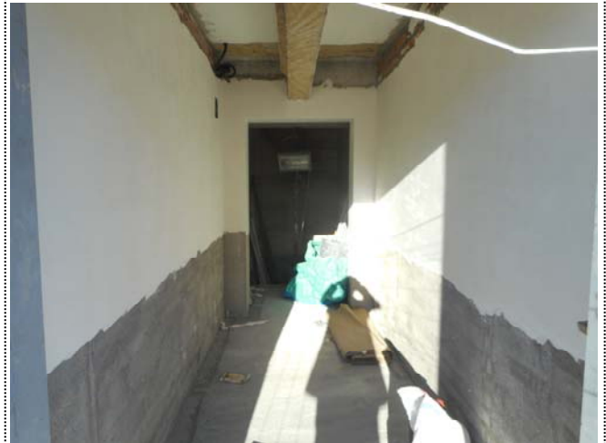
Foto 1819. 12/01/2015. Finalizado enlucido de paredes en nuevo vestíbulo (planta baja).
