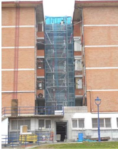
Foto 2032. 28/01/2015. Finalizando montaje de estructura metálica . Recuérdese: Entréguese a D.O. certificado del material (acero inoxidable, resistente al ambiente marino). Se reparará el pulido de las barras.
