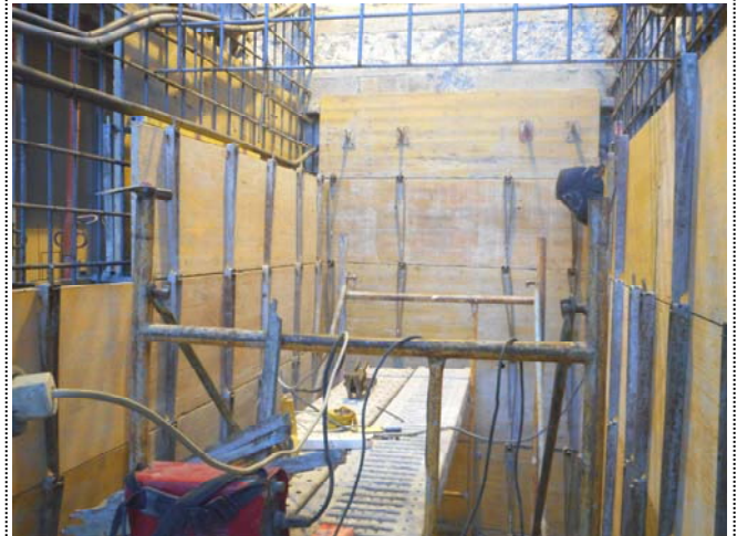
Foto 1649. 02/12/2014. Finalizando montaje de encofrado de muros. No olvidar pasatubos de ventilación (3 Ud) s/cabecal de puerta de recinto de ascensor. Colocados en horizontal, sobre el eje de la puerta (Cuidese la estética final).
