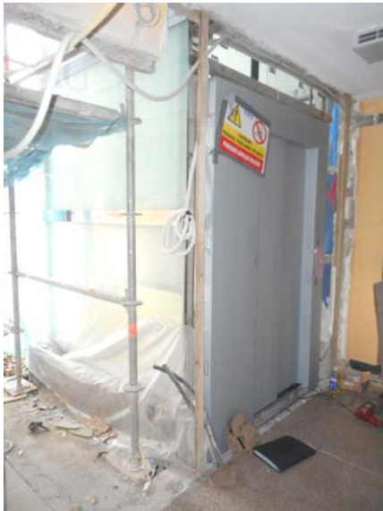
Foto 2620. 31/03/2015. Finalizando montaje de ascensor y colocación de puertas , en todas las plantas. Trabajando en el interior del recinto.
