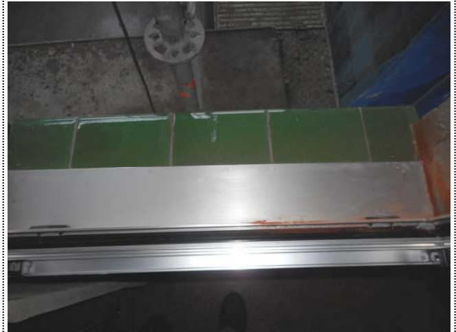
Foto 2276. 26/02/2015. Colocando las albardillas exteriores en los nuevos antepechos de ventanas. Cuidense los remates de bordes. Asegúrese la estanqueidad.
