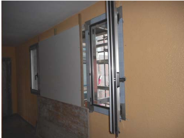
Foto 2275. 26/02/2015. Finalizada la colocación de ventanas .
