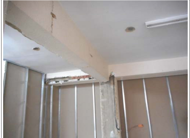
Foto 1397. 07/11/2014. Traslado al techo de la planta baja el replanteo exterior del recinto del ascensor (ver foto 1404).
