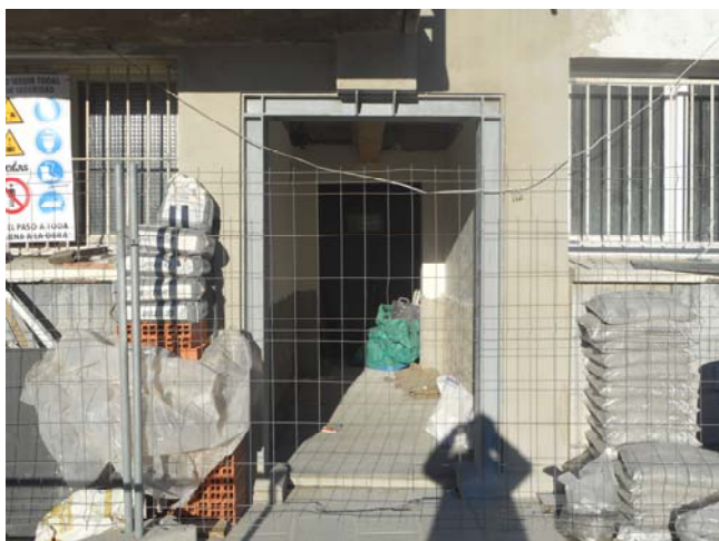
Foto 1820. 12/01/2015. Finalizado enfoscado de fachada . Ejecútense el sellado de la junta abierta, alrededor de la estructura metálica (Ligeramente rehundido).
