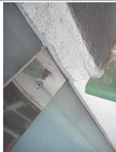
Foto 2960. 29/04/2015. Se comprueba el sellado del encuentro del acristalamiento del recinto con la fachada. Es correcto.
