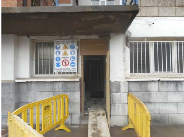
Foto 1396. 07/11/2014. Demolida parcialmente la fachada Sur de la plta. baja . Habilitado el acceso directo a la zona de obra desde el exterior. Sobre el cabezal ha aparecido una junta estructural por la que filtra agua (ver foto 1411).
