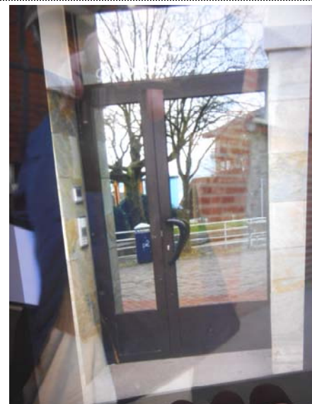
Foto 1771. 22/12/2014. El Constructor muestra a la Comisión diversos modelos de puertas . Se construirá una hoja con zócalo metálico (h: 40 cm) y tirador alrededor de la cerradura (similar a la expuesta en la foto).
