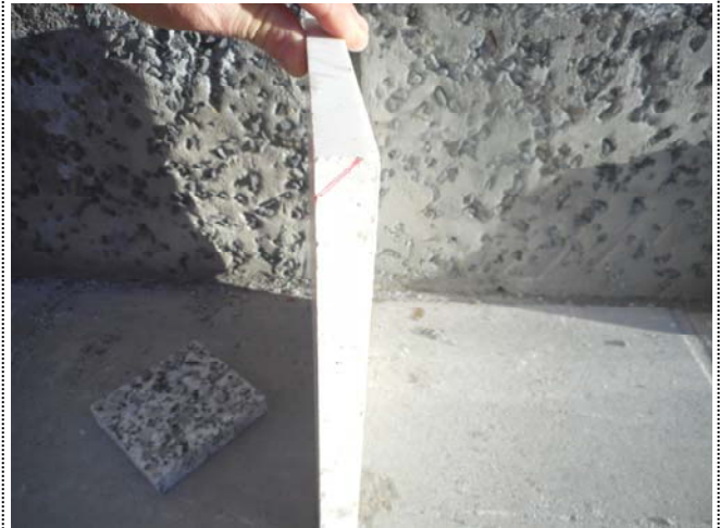
Foto 1769. 22/12/2014. Se precisa el remate achaflanado del borde superior del zócalo de paredes interiores del vestíbulo (s/placas de mármol).
