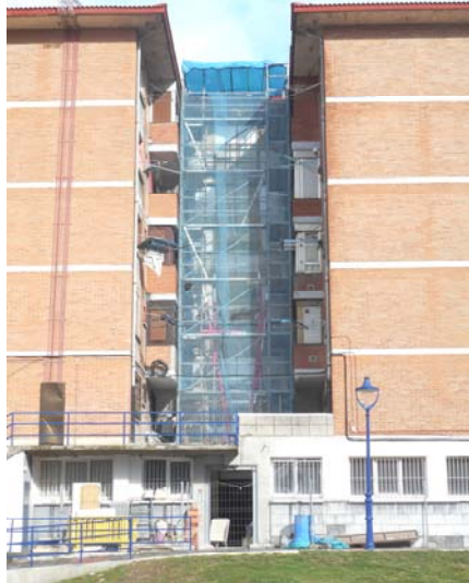
Foto 2015. 23/01/2015. Iniciando montaje de estructura metálica del recinto del ascensor. Solicítese al metalista un certificado del tipo de acero inoxidable (resistente al ambiente marino). Compruébese replanteo de la planta.
