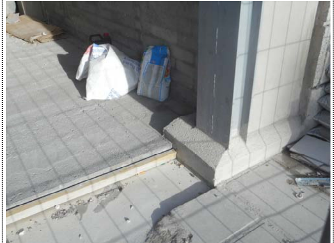
Foto 1871. 14/01/2015. Extendida la capa compresora s/suelo del nuevo vestíbulo (plta. baja). Finalícese las actuaciones pendientes en esta zona.
