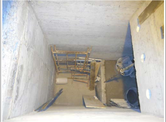
Foto 1726. 11/12/2014. Finalizada la ejecución de los suelos del recinto. Retírense todos los materiales y medios auxiliares sobrantes.
