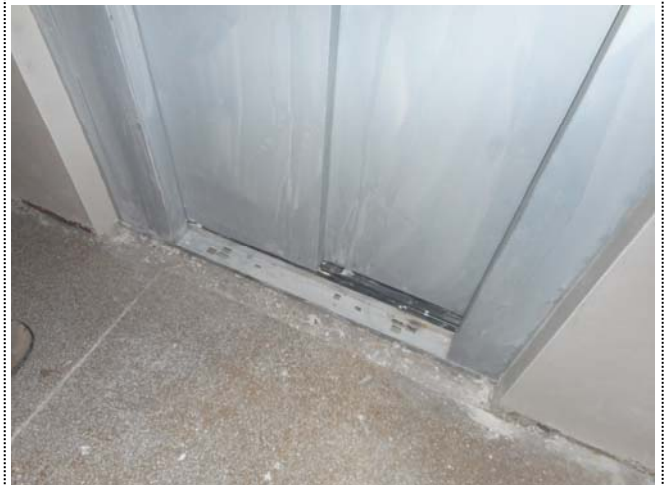
Foto 2963. 29/04/2015. Se comenta la colocación del umbral de salida del ascensor. Ejecútense con piezas de granito. Cuidense la nivelación y los remates.
