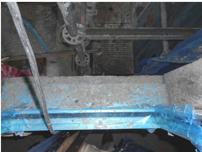
Foto 2277. 26/02/2015. Se comprueba disposición de protecciones de la carpintería . Es necesario mantenerlas hasta la entrega de la obra terminada.
