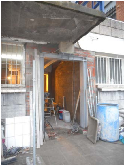
Foto 1734. 17/12/2014. Retirados apuntalamientos de planta baja. Comprobado asiento de cabezal de puerta. No hay.
