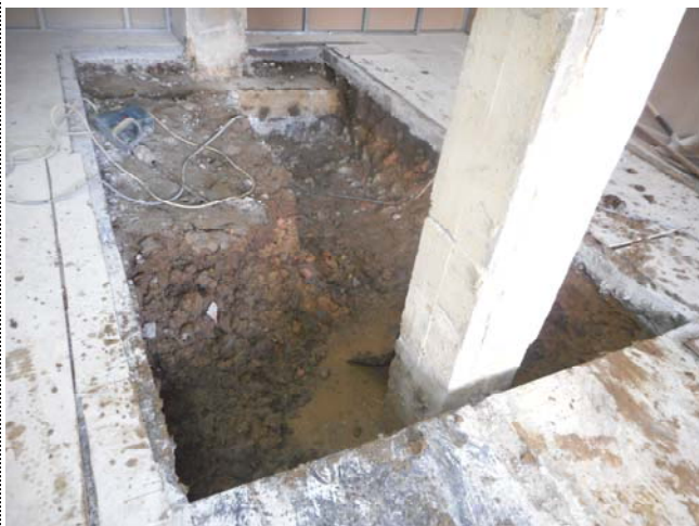
Foto 1400. 07/11/2014. Excavando foso del recinto.
