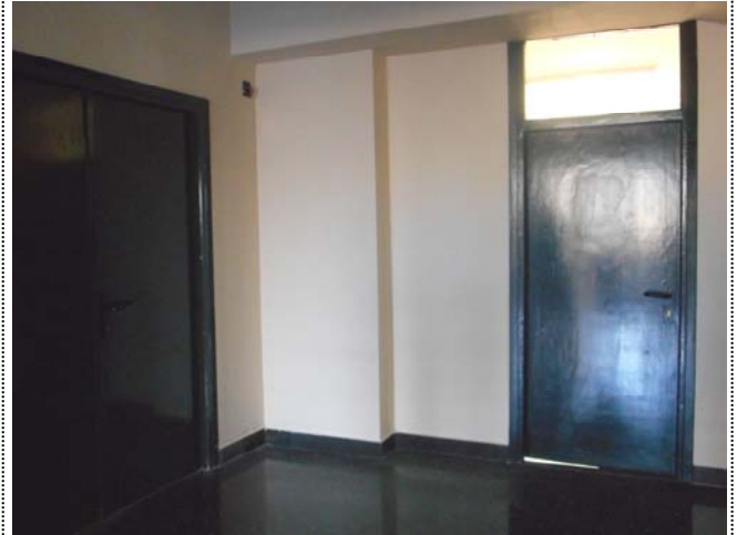
Foto 1883. 14/01/2015. Se comprueban los acabados de las paredes en el local de la BBK (zona de vestíbulo). Son correctos.
