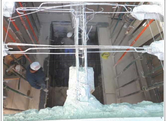
Foto 1521. 20/11/2014. Colocando impermeabilización y drenaje del foso del ascensor. Asegúrese que la lámina horizontal se levanta sobre los planos verticales, sin dobleces ni juntas separadas. Se comprueba replanteo del recinto en planta baja. Es correcto.
