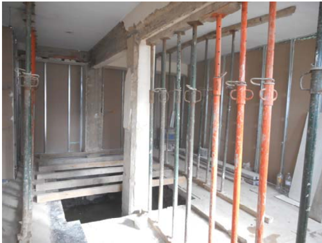
Foto 1497. 18/11/2014. Apeados bordes del forjado a demoler (se mantendrán así hasta que el D.O. de orden explícita de retirada de los puntales).
