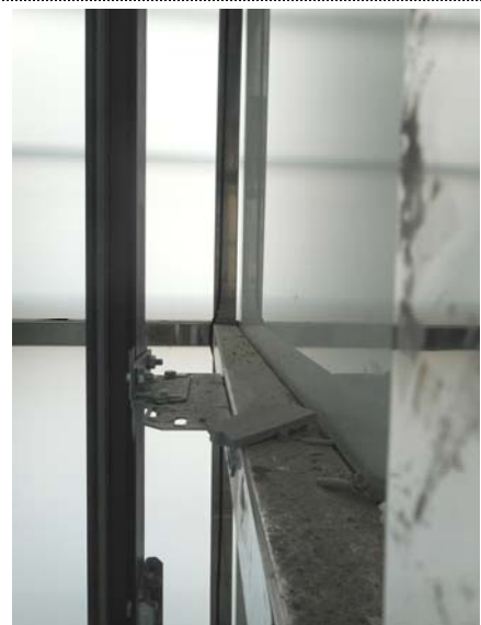
Foto 2765. 15/04/2015. Se comprueba limpieza del interior del recinto del ascensor . Es necesario retirar restos de obra y limpiarlo con esmero (metal y vidrios).
