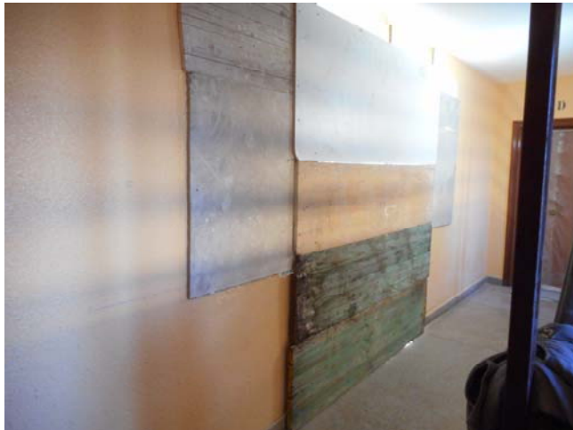
Foto 1823. 12/01/2015. Se comprueba protección de huecos . Asegúrese que no pueden ser removidos por personas ajenas a la obra.
