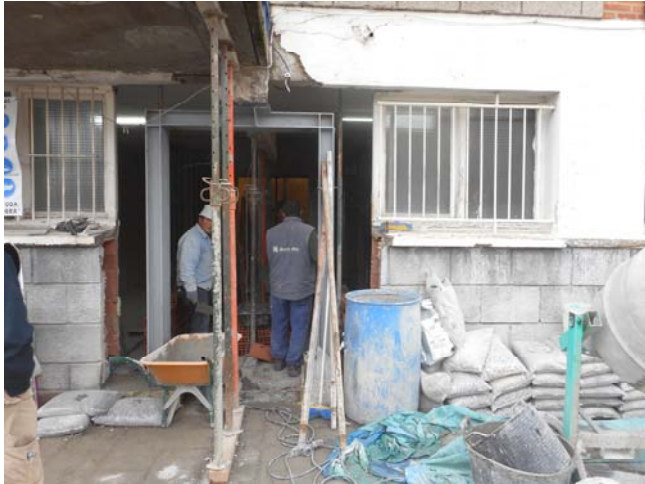
Foto 1716. 10/12/2014. Finalizado el montaje del nuevo pórtico de acceso. Antes de retirar los puntales, se aflojarán y se comprobará el asiento del nuevo cabezal puesto en carga.
