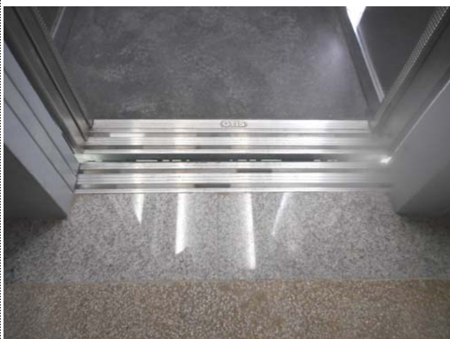
Foto 8196. 02/06/2015. Se comprueba enrasado de cabina de ascensor con rellanos de escaleras . Es correcto.
