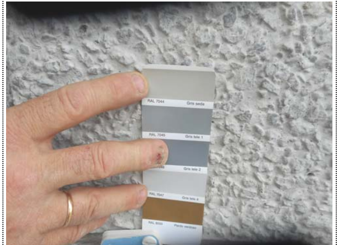
Foto 8194. 02/06/2015. Se selecciona color del recercado de la nueva puerta : RAL 7045. Asegúrese el perfilado esmerado en el perímetro de encuentro exterior con la pared blanca.
