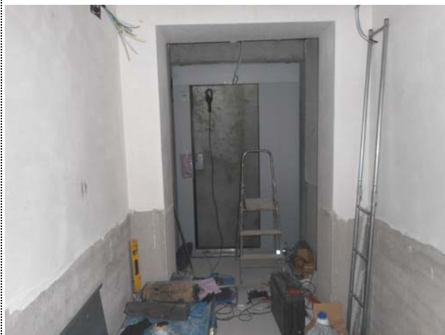
Foto 2628. 31/03/2015. Ejecutada la instalación eléctrica en el nuevo vestíbulo. Preparando recibido de puerta de ascensor.
