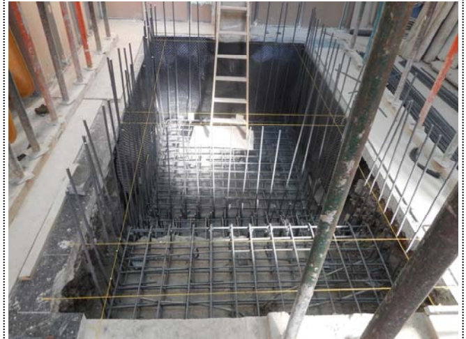
Foto 1531. 21/11/2014. Se comprueba el armado de la zapata y la colocación de las esperas para el nuevo armado de los muros.
