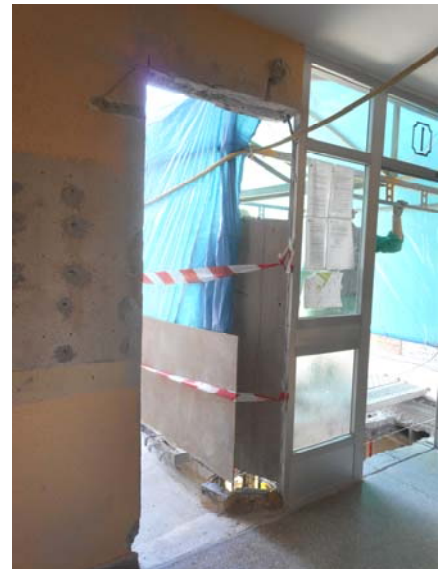
Foto 1518. 20/11/2014. Abierto nuevo acceso al portal. Disponiendo protecciones para evitar caídas al vacío. ¡Ojo! ¡No olvidar a los niños!. Esmérese la seguridad de las protecciones.
