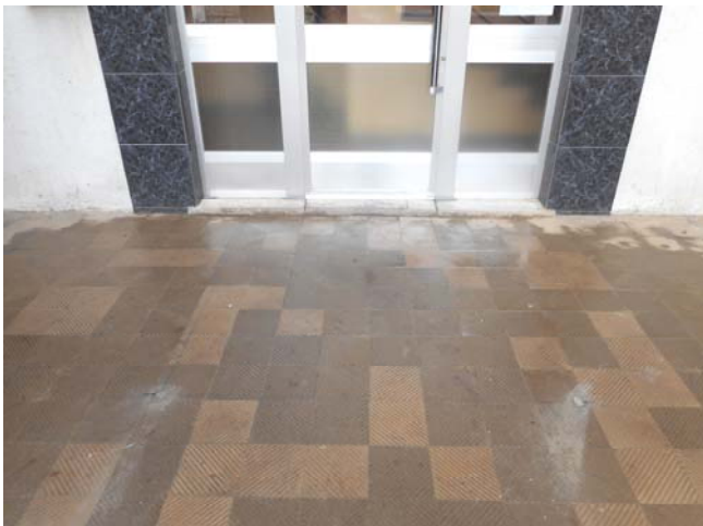
Foto 1404. 07/11/2014. Se comprueba el replanteo exterior del recinto del ascensor . Es correcto.
