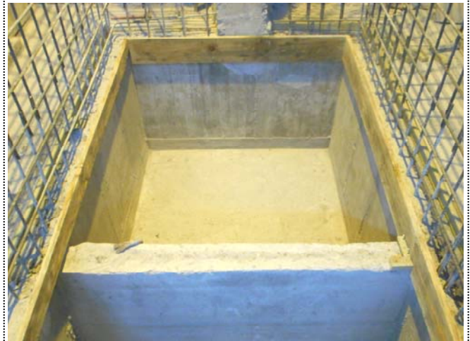
Foto 1627. 01/12/2014. Desencofrado la totalidad del foso. No hay coqueas. La compactación del hormigón ha sido correcta.
