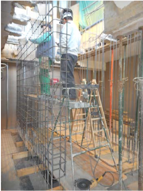
Foto 1566. 27/11/2014. Montando ferralla de muros.
