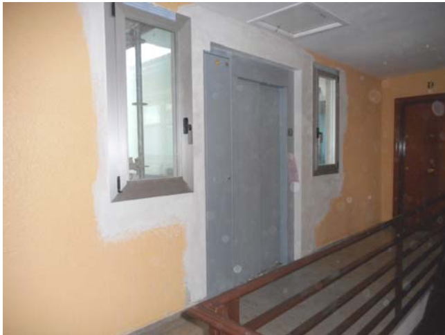
Foto 2961. 29/04/2015. Finalizados remates de huecos en el interior de las escaleras (todas las pltas). Antes de pintar es necesario asegurar el secado del soporte.
