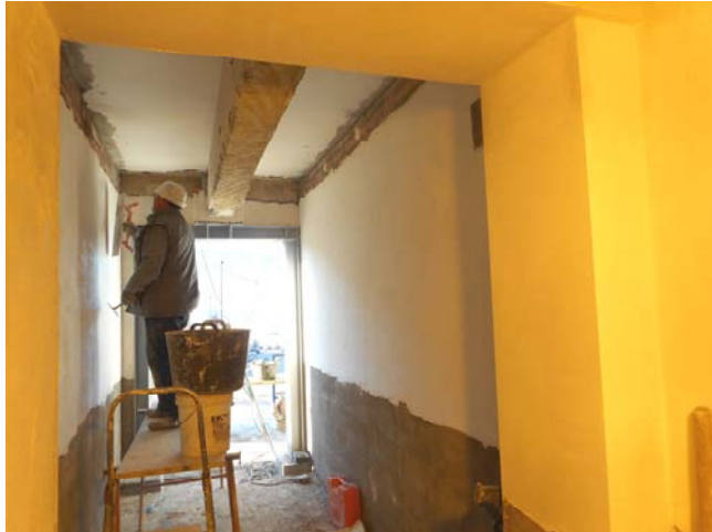
Foto 1778. 22/12/2014. Ejecutando enlucido s/paredes interiores de nuevo vestíbulo . Antes de pintar asegúrese el secado.
