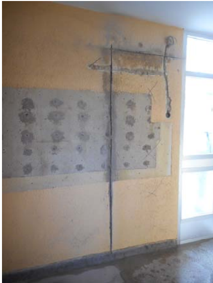
Foto 1490. 18/11/2014. Iniciando apertura de nueva puerta de portal . Realizado el replanteo y precorte. Actúese con diligencia y evítese la producción de polvo.
