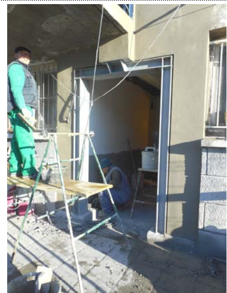
Foto 1775. 22/12/2014. Rematando revestimiento de fachada exterior.
