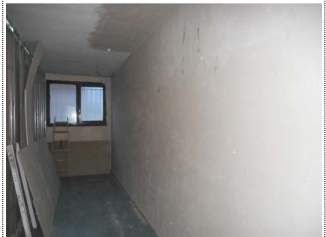
Foto 1739. 17/12/2014. Ejecutando el guarnecido de paredes de BBK (zona gimnasio). Antes de pintar se asegurará el secado de la pared. Compruébese con un humidímetro. El pintor se responsabilizará de las condiciones del soporte.
