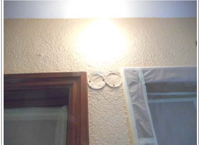
Foto 3056. 12/05/2015. Se dan directrices para situar el aluminado de emergencia en las plantas de viviendas . Se situarán entre las cajas de distribución y la luminaria existente, frente al desembarco de la escalera (subiendo).
