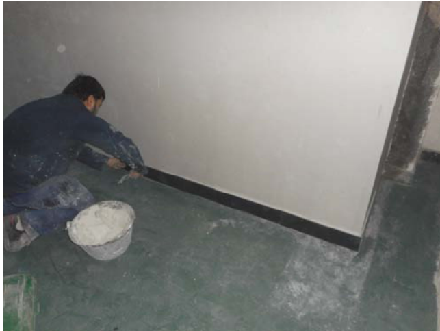
Foto 1740. 18/12/2014. Iniciando colocación de rodapiés/paredes BBK (zona gimnasio). Asegúrese el encolado de las piezas.
