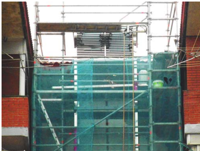
Foto 2186. 18/02/2015. Finalizado el montaje de estructura metálica.
