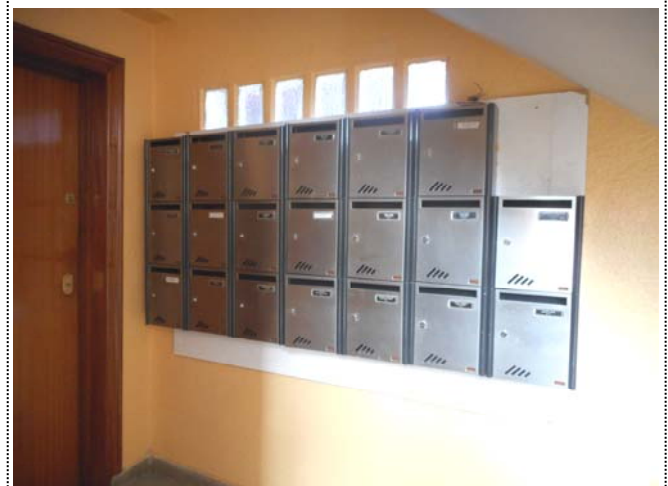
Foto 1489. 18/11/2014. Se comprueba reubicación provisional de buzones .
