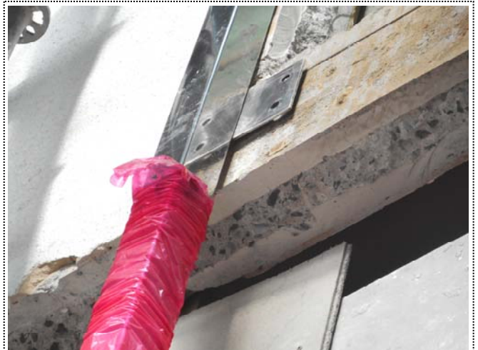
Foto 2020. 23/01/2015. Preparando anclaje de estructura a frentes de forjados. Cuidese su ejecución, con extraordinario esmero. Asegúrese el contacto total entre las placas metálicas y los forjados, mediante juntas de asiento. Las soldaduras con los tubos serán continuas, a todo lo largo de los encuentros. Véase detalle, plano 217/PE09. Debe asegurarse la estabilidad e indeformabilidad de la estructura. Manténganse todos los perfiles protegidos, hasta la colocación del vidrio. Evítense rayados.
