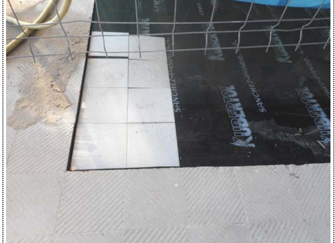
Foto 1741. 18/12/2014. El Constructor presenta una muestra de baldosas para el pavimento del patio. Se exhibirán las muestras de los distintos revestimientos proyectados a los representantes de la Cdad.; el próximo lunes.
