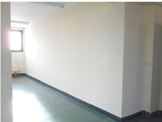
Foto 1884. 14/01/2015. Se comprueban los acabados de las paredes en el local de la BBK (zona de gimnasio y cruz roja). Son correctos.
