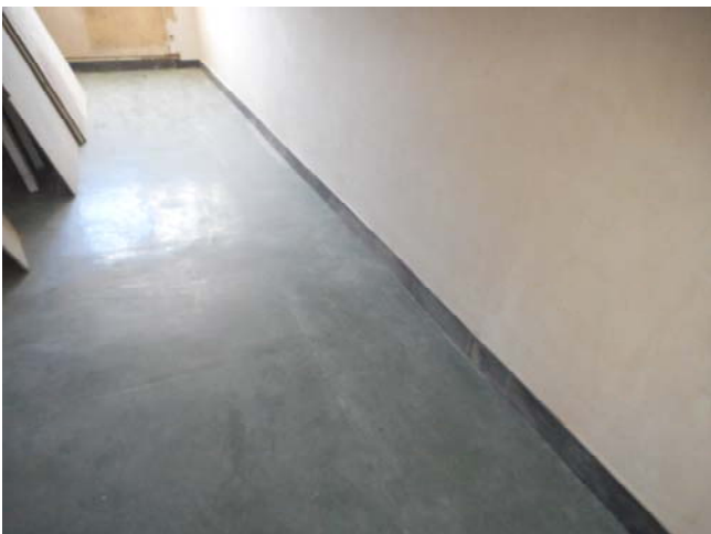
Foto 1781. 22/12/2014. Finalizada la colocación de rodapiés s/pared BBK (zona gimnasio) . Limpíese el pavimento. Manténgase la delimitación de la zona hasta terminar los acabados.
