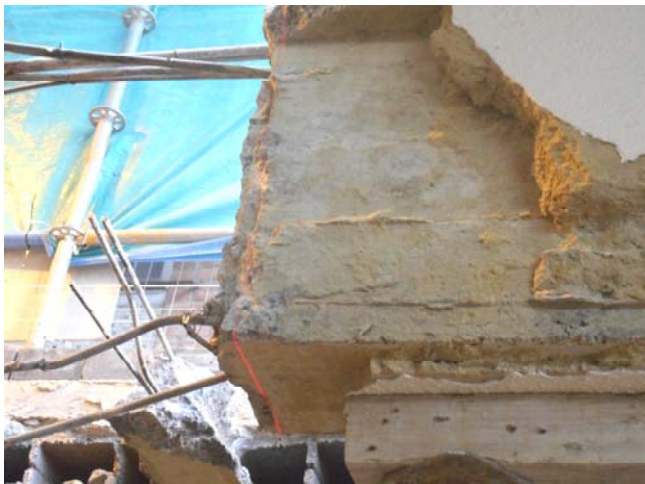
Foto 1545. 24/11/2014. Se dan instrucciones para apoyar la jácena cortada sobre el nuevo muro (Según se señala con el láser). La mitad de los negativos se doblarán hacia el interior del muro; la otra mitad se anclarán, en prolongación, sobre los mallazos del nuevo forjado.
