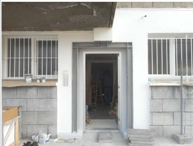
Foto 3064. 12/05/2015. Pintando exterior de fachada de planta baja. Cuidese el perfilado del perímetro exterior de la pintura de la estructura metálica , en su encuentro con el revestimiento (blanco) de la pared.
