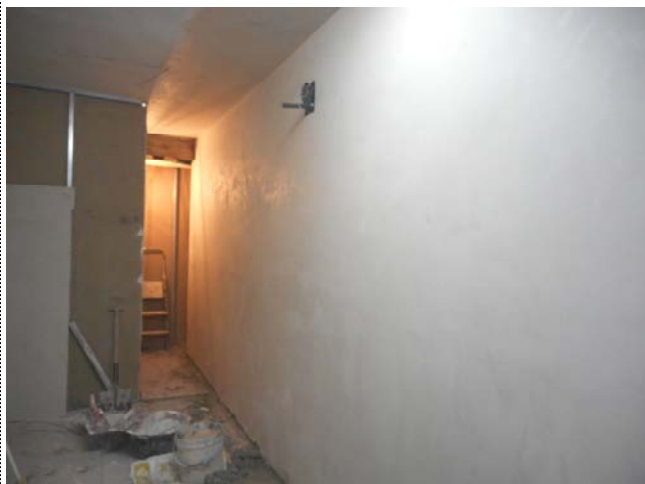
Foto 1737. 17/12/2014. Ejecutando el guarnecido de paredes de BBK (zona Cruz Roja). Antes de pintar se asegurará el secado de la pared. Compruébese con un humidímetro. El pintor se responsabilizará de las condiciones del soporte.
