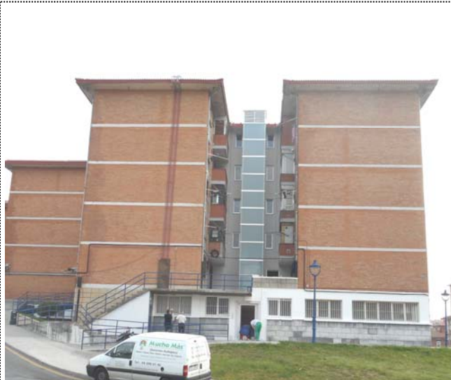
Foto 8193. 02/06/2015. Rematando finalización de la obra . Colocando umbral de acceso al nuevo portal, en plta "BBK".
