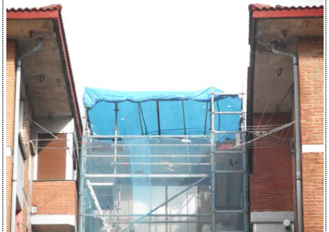
Foto 2016. 23/01/2015. La cubrición provisional de la zona de trabajo sobre la cubierta debe afianzarse con total seguridad para evitar que puedan producirse incidencias ocasionadas por el viento.
