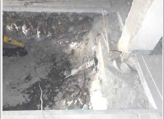
Foto 1447. 12/11/2014. Excavando foso de ascensor . Ha aparecido roca muy compacta. Opone gran resistencia a la excavación. Recórtese todo el perímetro proyectado, incluida zona adyacente al pilar, sin apurar la aproximación a la cara del mismo.
