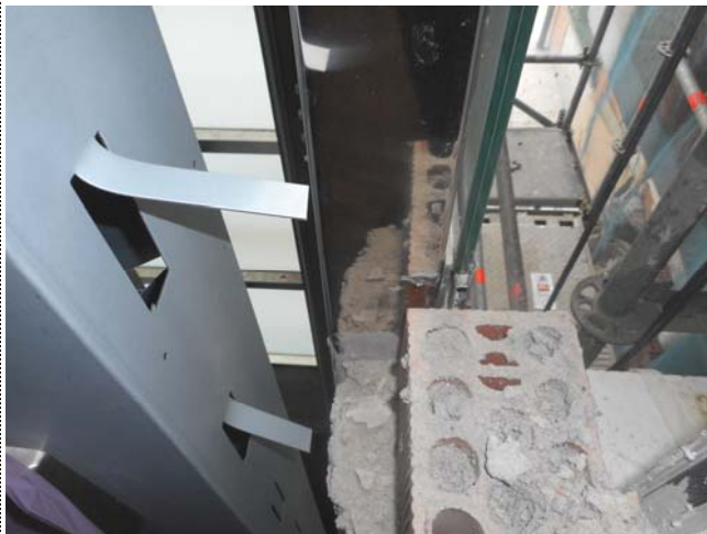
Foto 2623. 31/03/2015. Los marcos de puertas del ascensor se fijarán a las mochetas laterales con todas las pestañas disponibles introducidas en la fábrica de ladrillo . El encuentro entre los vidrios del recinto y el plano de fachada se sellará, con esmero; antes de ejecutar el sellado comuníquese a la Dirección de obra .
