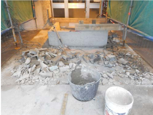
Foto 1725. 11/12/2014. Demoliendo pavimento de patio, preparando soporte para impermeabilización. Se realizará una prueba de estanqueidad después de colocar la membrana y antes de colocar nuevo pavimento.
