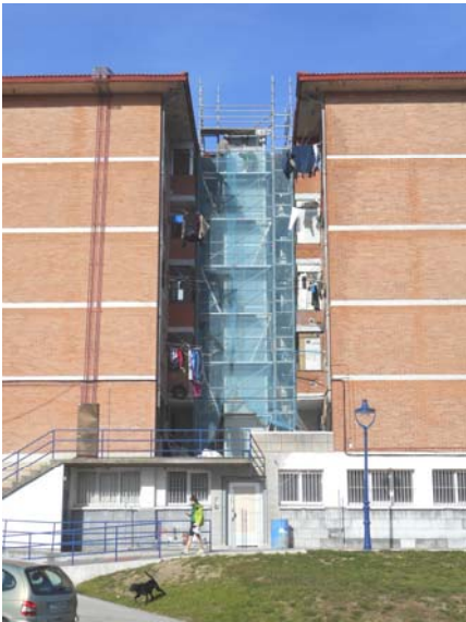
Foto 2321. 10/03/2015. Colocado cerramiento de vidrio del recinto exterior. Iniciando sellados (véase notas s/foto 2329). Advertencia: los operarios deben utilizar los EPI (casco); cualquier operario que incumpla directrices de seguridad será apartado inmediatamente de la obra.
