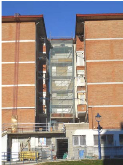
Foto 1818. 12/01/2015. Finalizando demolición de frente de fachada . Compruébense medidas de huecos. Antes de demoler el borde de la cubierta, compruébese afección s/el alero y condiciones de desagüe del pesebre. Dispóngase una nueva barra horizontal sobre la coronación del andamio . Los operarios deben utilizar arnés s/el tejado.
