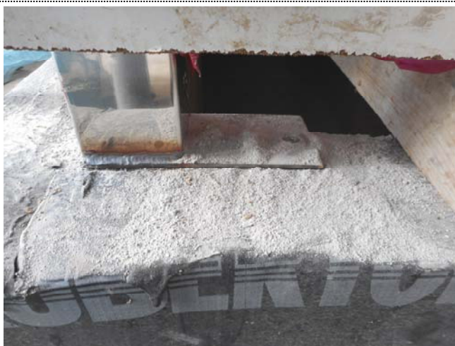
Foto 2019. 23/01/2015. Preparando apoyos de estructura metálica sobre paredes de h.a. Cuidese su ejecución, con especial esmero. Véase el detalle E del plano 217/PE10. Los tubos horizontales deben apoyan sobre las paredes a todo lo largo, en su totalidad, interponiendo una junta de asiento (de neopreno). Las soldaduras entre perfiles serán continuas, en todo el perímetro del encuentro.
