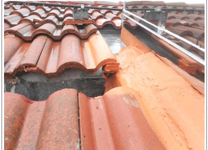
Foto 2952. 29/04/2015. Se comprueba desague de bandeletas del remate sobre los pesabres del alero. Es correcto. No se aprecia riesgo de filtraciones..
