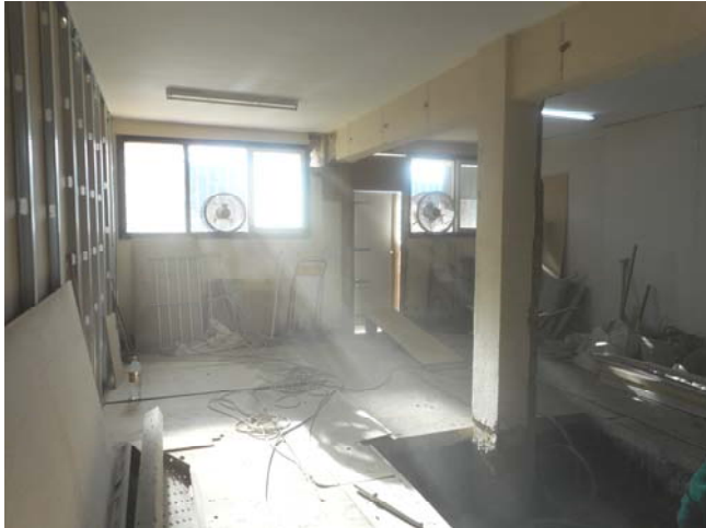
Foto 1446. 12/11/2014. Se comprueba condiciones de trabajo . Se han dispuesto extractores de aire. Los operarios disponen de mascarillas, protectores de oídos y gafas. Las están utilizando.
