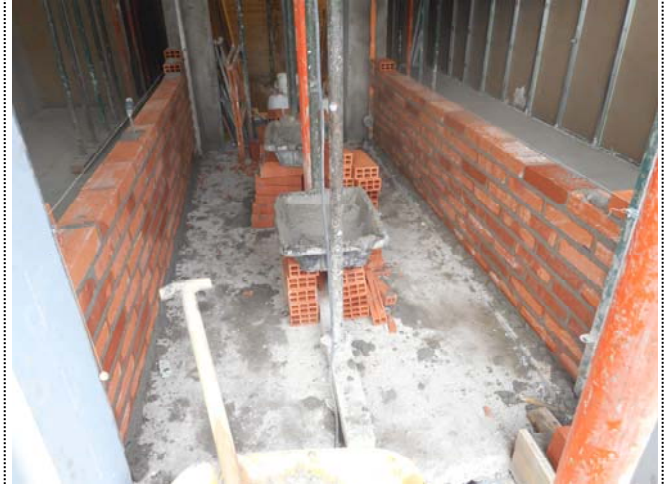
Foto 1719. 10/12/2014. Construyendo tabiques de separación entre nuevo portal y BBK. Es necesario habilitar accesos provisionales desde BBK para realizar los revestimientos en esa zona. ¡Ojo! No pintar hasta asegurar que el nuevo revestimiento esté seco. Asegúrese.
