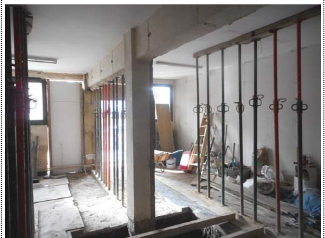
Foto 1496. 18/11/2014. Apeada la viga exterior (se mantendrán así hasta que el D.O. de orden explícita de retirada de los puntales).
