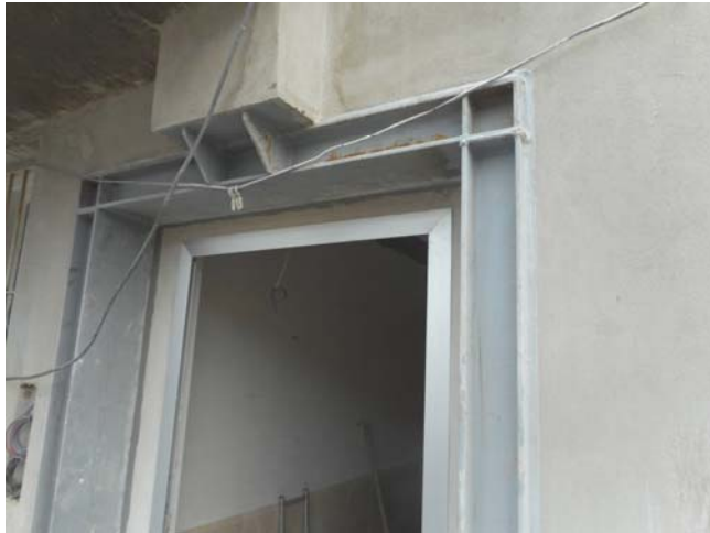
Foto 2971. 29/04/2015. Se han ejecutado los sellados perimetrales (exteriores e interiores) de las juntas entre fachada y estructura metálica del acceso.
