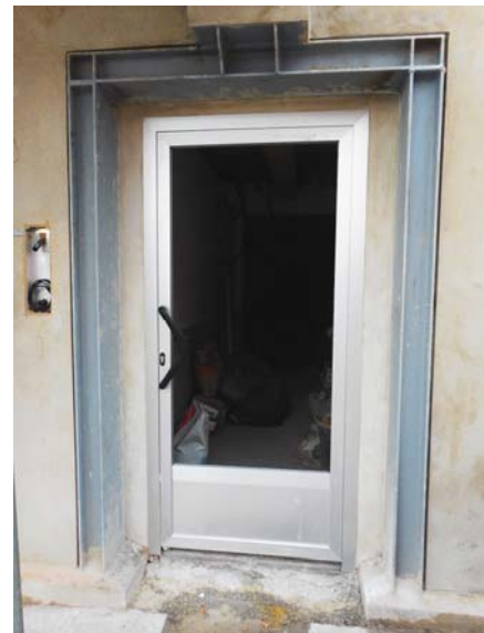
Foto 2188. 18/02/2015. Colocada puerta de acceso en "planta BBK".
