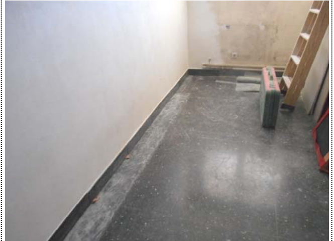
Foto 1780. 22/12/2014. Finalizada la colocación de rodapiés s/pared BBK (zona Cruz Roja) . Limpíese el pavimento. Manténgase la delimitación de la zona hasta terminar los acabados.
