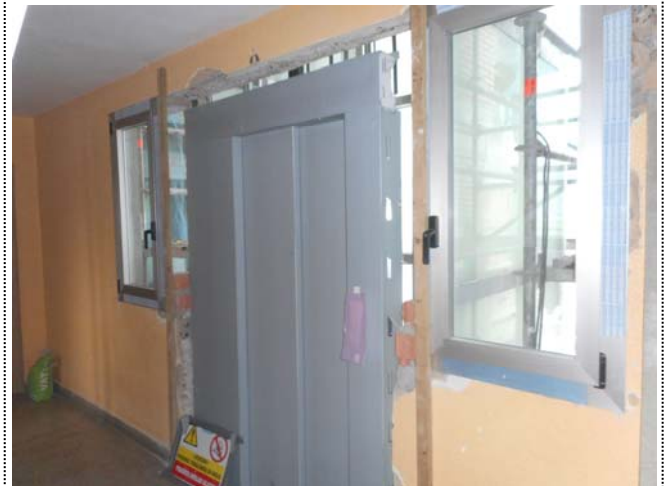
Foto 2624. 31/03/2015. Se dan directrices para la construcción de mochetas alrededor de las puertas del ascensor . El eje del hueco resultante coincidirá con el eje de simetría entre ventanas .
