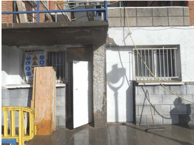
Foto 1484. 18/11/2014. Finalizada la demolición de fachada . Descubierto el pilar a demoler.
