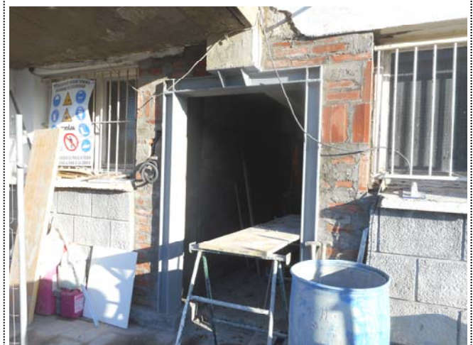
Foto 1743. 18/12/2014. Preparando instalación de portero automático en la puerta de la planta baja.
