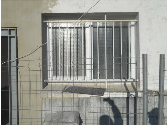
Foto 1882. 14/01/2015. Se han repasado los remates de las "ventanas de la BBK" , colocando los tapajuntas necesarios en el interior y renovando la pintura de la carpintería.
