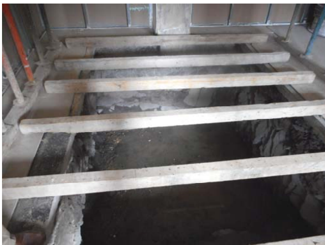
Foto 1492. 18/11/2014. Finalizada la excavación del foso . Extiéndase el hormigón de limpieza y replantéese, con precisión, la planta del recinto (dibújese sobre el suelo).
