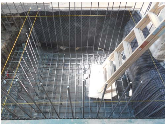
Foto 1532. 21/11/2014. Se comprueba impermeabilización de foso. Asegúrese que el vertido del hormigón de la zapata presiona la lámina impermeabilizante sobre la drenante. El hormigón no debe introducirse entre ellas.
