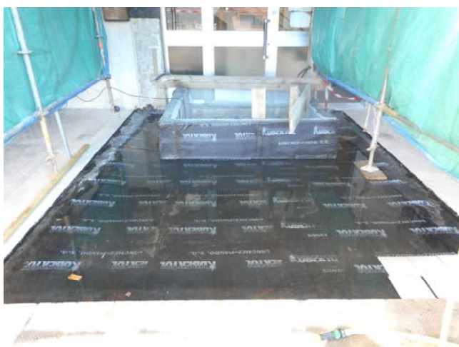
Foto 1742. 18/12/2014. Ejecutada impermeabilización del suelo del patio (zona intervenida). Realizándose prueba de estanqueidad. Manténgase mientras no sea necesario intervenir en la zona.
