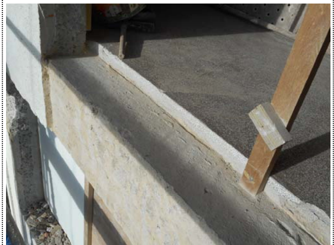
Foto 1881. 14/01/2015. Se han recortado los umbrales de los accesos al ascensor en las plantas de las escaleras. Evítense daños en el terrazo "in situ". Se darán directrices para ejecutar los nuevos remates.
