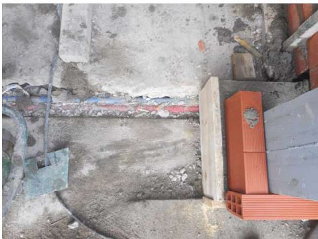
Foto 1722. 10/12/2014. Finalizado el montaje de los nuevos tubos de calefacción.
