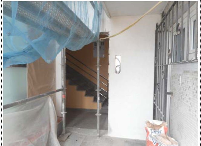
Foto 3060. 12/05/2015. Finalizando pintado de la fachada principal . Vigílese el desmontaje del andamio para evitar dañarla.
