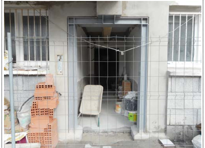
Foto 2027. 23/01/2015. Preparando instalación de portero automático en nuevo vestíbulo . Aváncese en la finalización de los acabados de esta zona.
