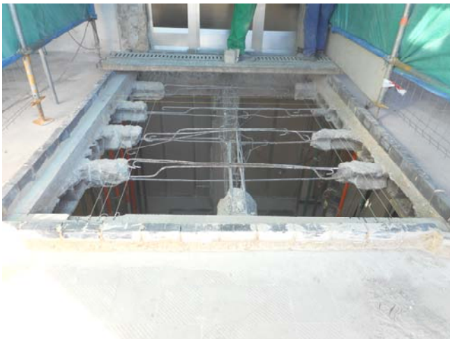
Foto 1520. 20/11/2014. Ejecutado recrecido perimetral para evitar la introducción de lluvia en el interior del hueco. Manténgase hasta que el D.O. autorice la retirada. Investiguese la situación de la impermeabilización del forjado.
