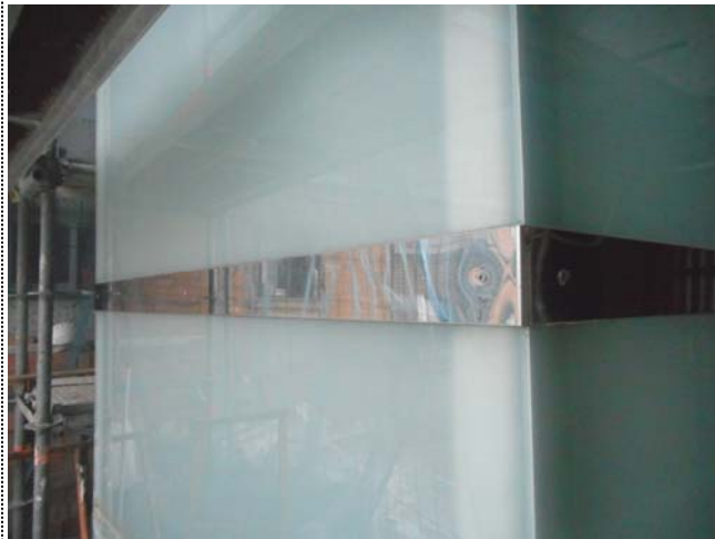
Foto 2626. 31/03/2015. Se comprueban remates de perfiles exteriores de fijación de vidrios. Protéjase hasta la entrega de la obra, evítense las rayaduras.
