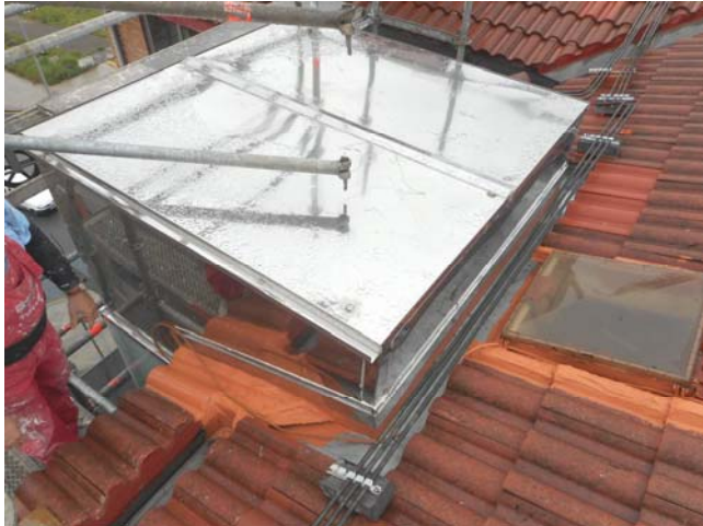
Foto 2944. 29/04/2015. Se inspeccionan remates de encuentro de casetón de ascensor de tejado. Es correcto. De las explicaciones dadas por el Constructor sobre la ejecución del encuentro puede deducirse que la impermeabilización del encuentro está asegurada.
