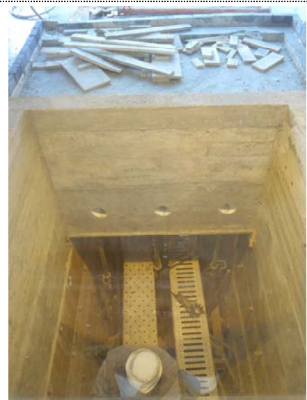
Foto 1654. 5/12/2014. Se comprueba disposición de pasos de ventilación cruzada del recinto.
