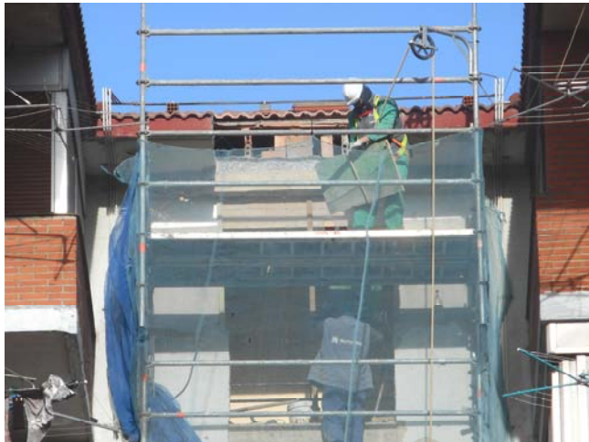
Foto 1870. 14/01/2015. Finalizando demolición de alero . El D.O. dará directrices para ejecutar el remate con el recinto del ascensor.
