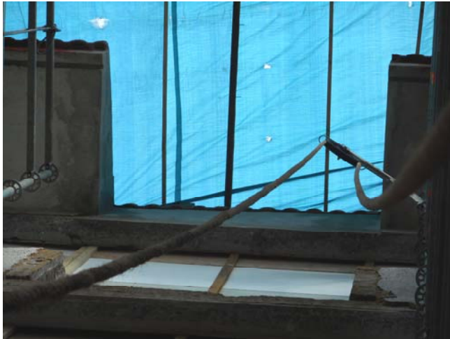
Foto 2023. 23/01/2015. Rematando recortado de borde de alero .
