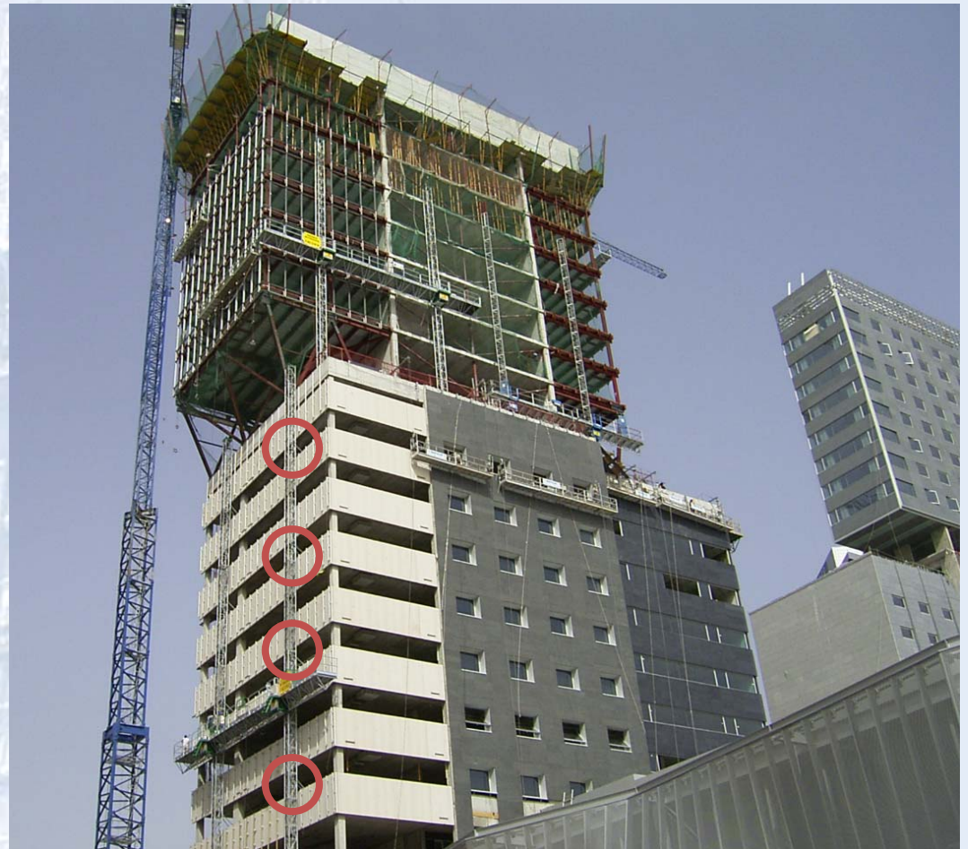
ANCLAJE SIN CONTACTO A FACHADA
