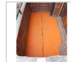
Impermeabilización de la terraza.
