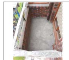
Picado de suelo existente (hasta el forjado).
