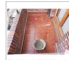
Colocación de rodapié perimetral sobre paramentos verticales, incluyendo perfilas de encuentro con suelo y de remate superior.
