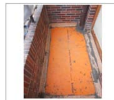
Remates perimetrales de la impermeabilización sobre paramentos verticales.
